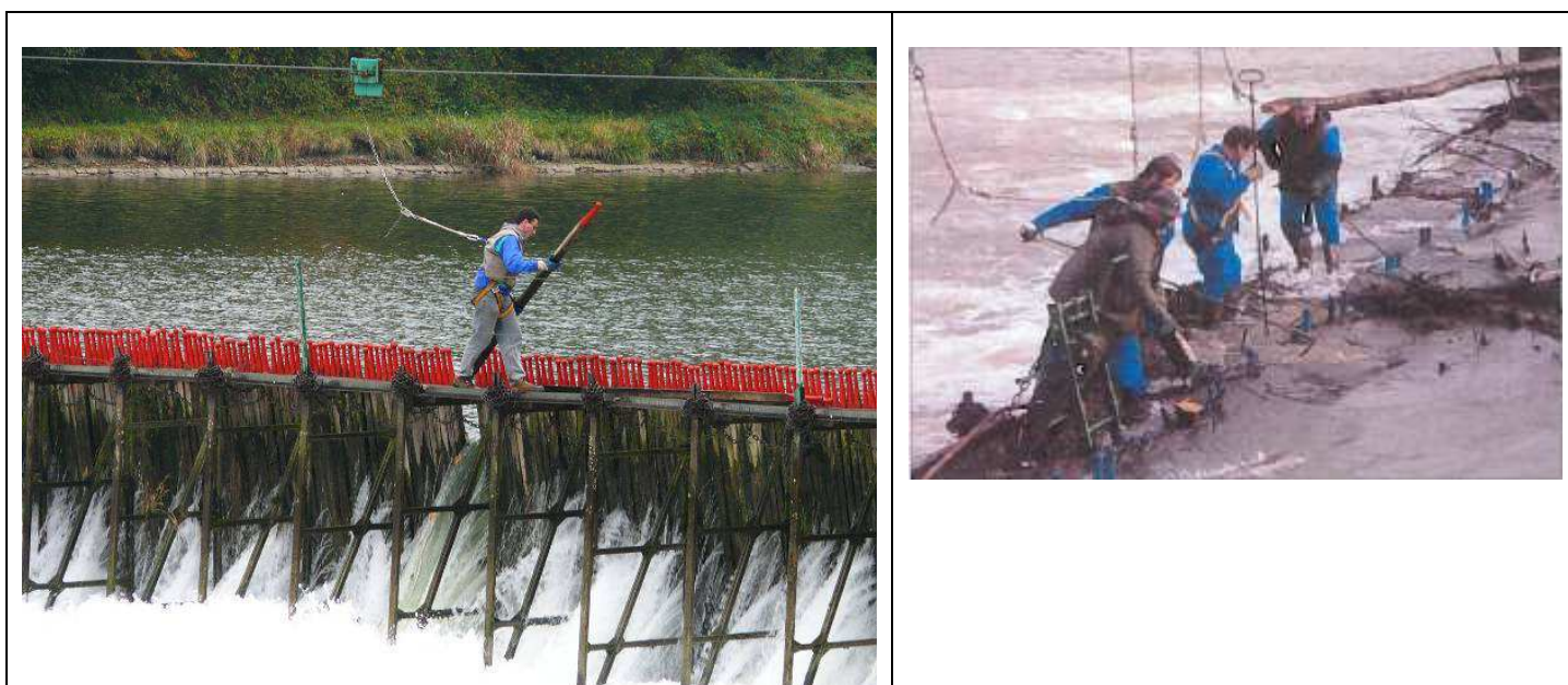
Figure 3 : barrage à aiguilles : dépose d'une aiguille (source : wikipédia et photo prise sur la Meuse par les rapporteurs)
