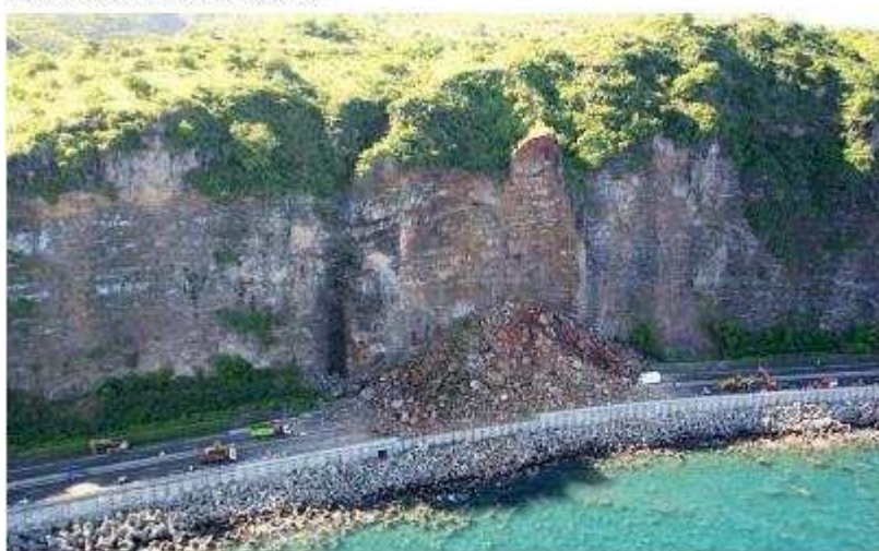
L'éboulement du 24 mars 2006
