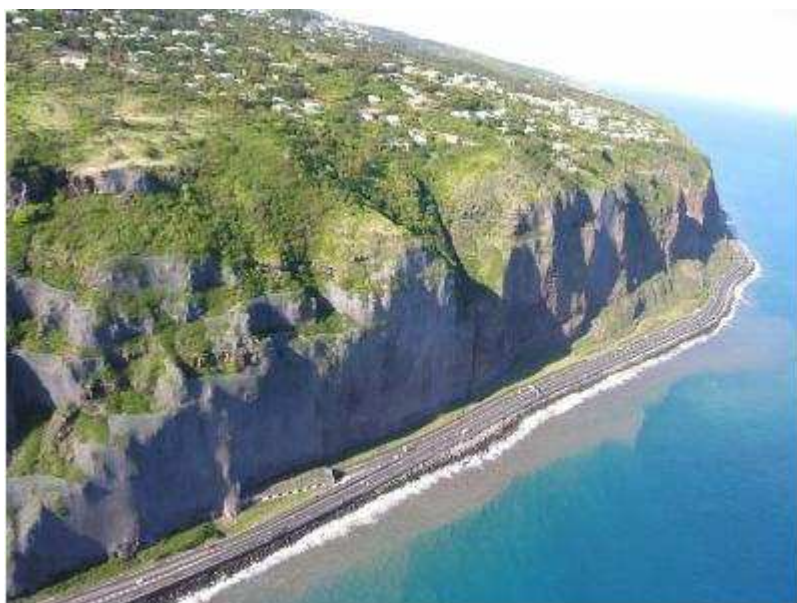
Cliché : Egis Route, mai 2007.
